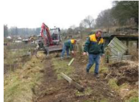
Eer foto 'uit de oude doos': renovatiewerkzaamheden op De Kweek
